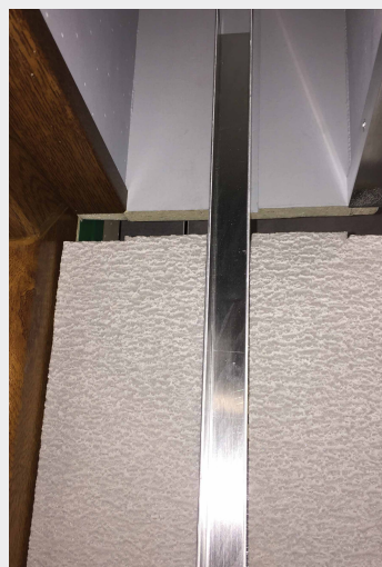
Ostění s vodicí lištou před aplikací zateplení fasády.
