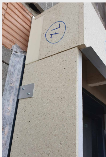
Ostění s vodicí lištou před aplikací zateplení fasády.
