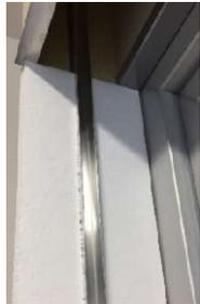
Es besteht aus einer stabilisierten Wärmedämmplatte aus Polystyrolschaum mit hohen Druckbelastungsanforderungen. In die Platte ist ein klassischer Außenjalousienkasten 25 x 23 mm eingelassen. Die Platte ist für die flächige Verklebung mit Schaumklebern vorgesehen. Maximale Länge in einem Stück 3500 mm (oder je nach Transportmöglichkeiten).
