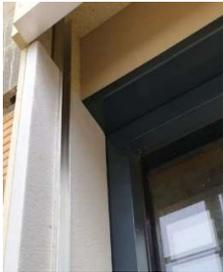
In ihm klebt ein Gehäuse aus extrudiertem Aluminium mit einer Überlappung von 150 mm in den Kasten. Im Preis inbegriffen sind L-Winkel für die Montage an einem 30 x 60 mm Fensterrahmen. Konsolen für die Montage in der Isolierauskleidung ( 120 x 80 mm) können gegen Aufpreis bestellt werden. Maximale Länge in einem Stück 3500 mm ( oder je nach Transportmöglichkeiten ).
